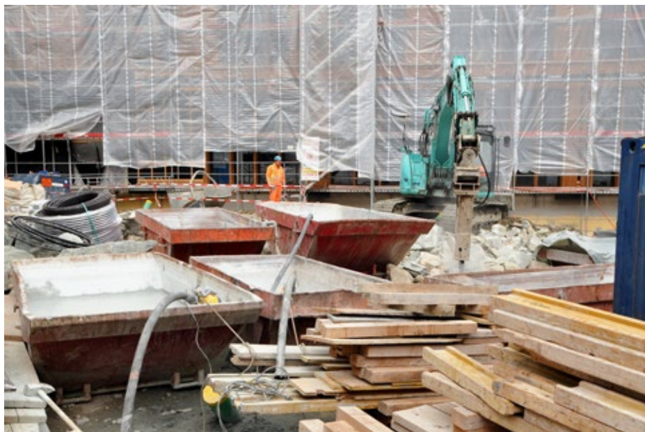
Avesco, Baustelle Zermatt, Erdsonden-Bohrgerät Klemm, Mulden für Bohrrückfluss.
