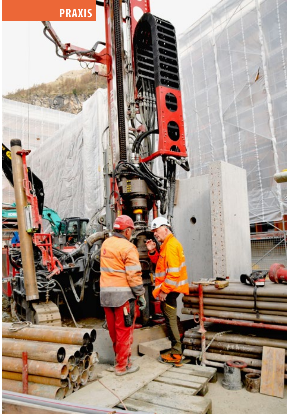
Avesco, Baustelle Zermatt, Erdsonden-Bohrgerät Klemm, Hilfsbohrmeister Bozo Tadic, Geowärme AG.
