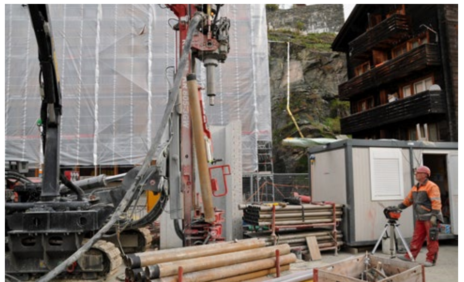
Avesco, Baustelle Zermatt, Erdsonden-Bohrgerät Klemm, Bohrmeister Savo Dragojlovic, Geowärme AG, Fernbedienung.
