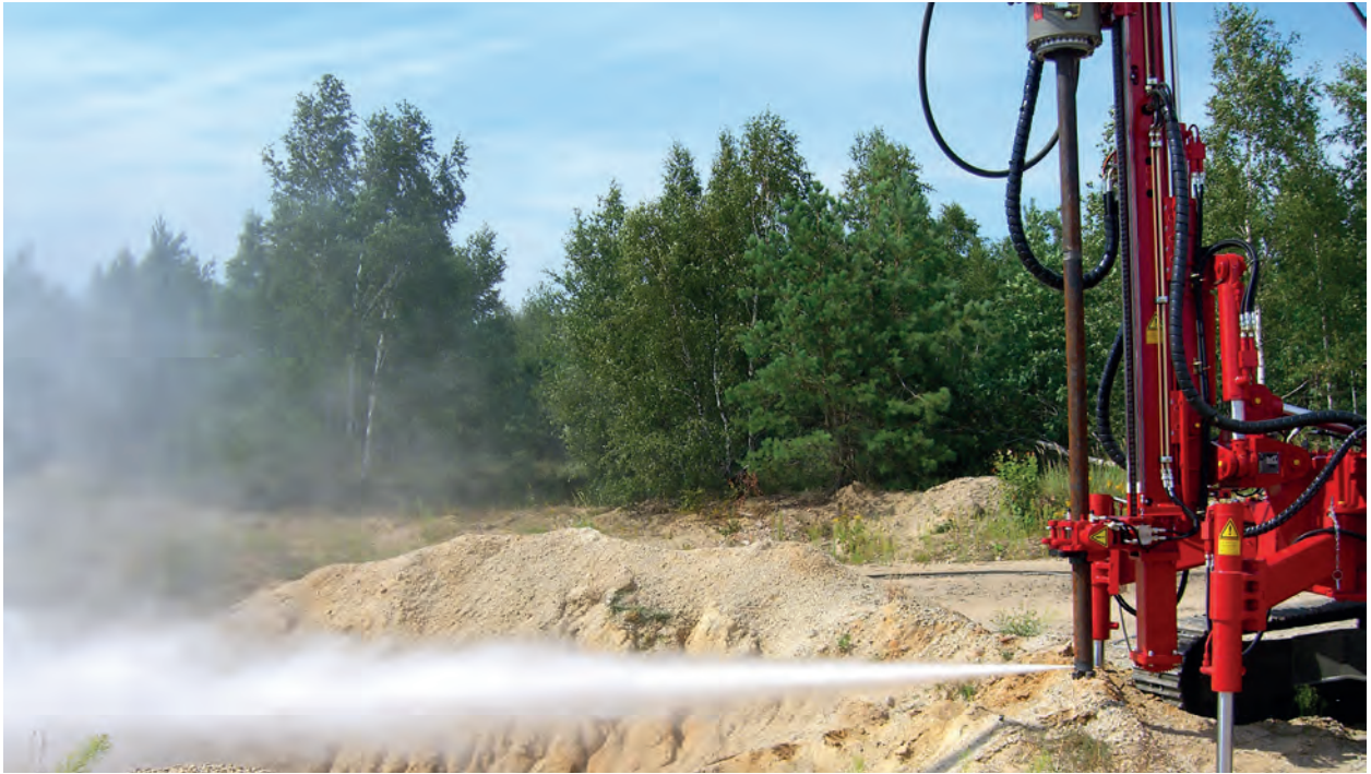
KLEMM HDI-Ausrüstung KLEMM jet grouting system
