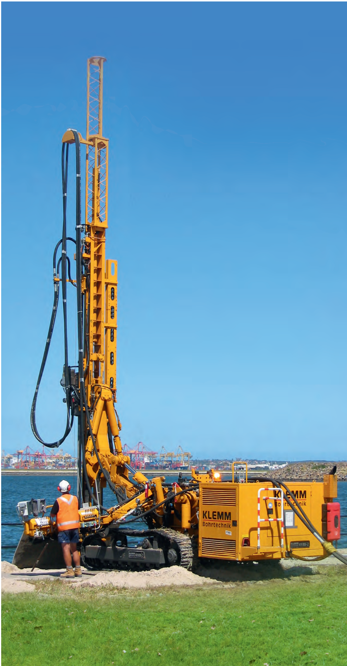
Hochdruckinjektionen High-pressure injections
